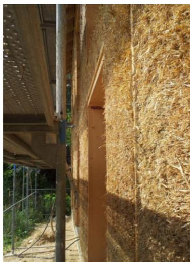
**Abbildung 2: Strohwand im eingebauten Zustand**
